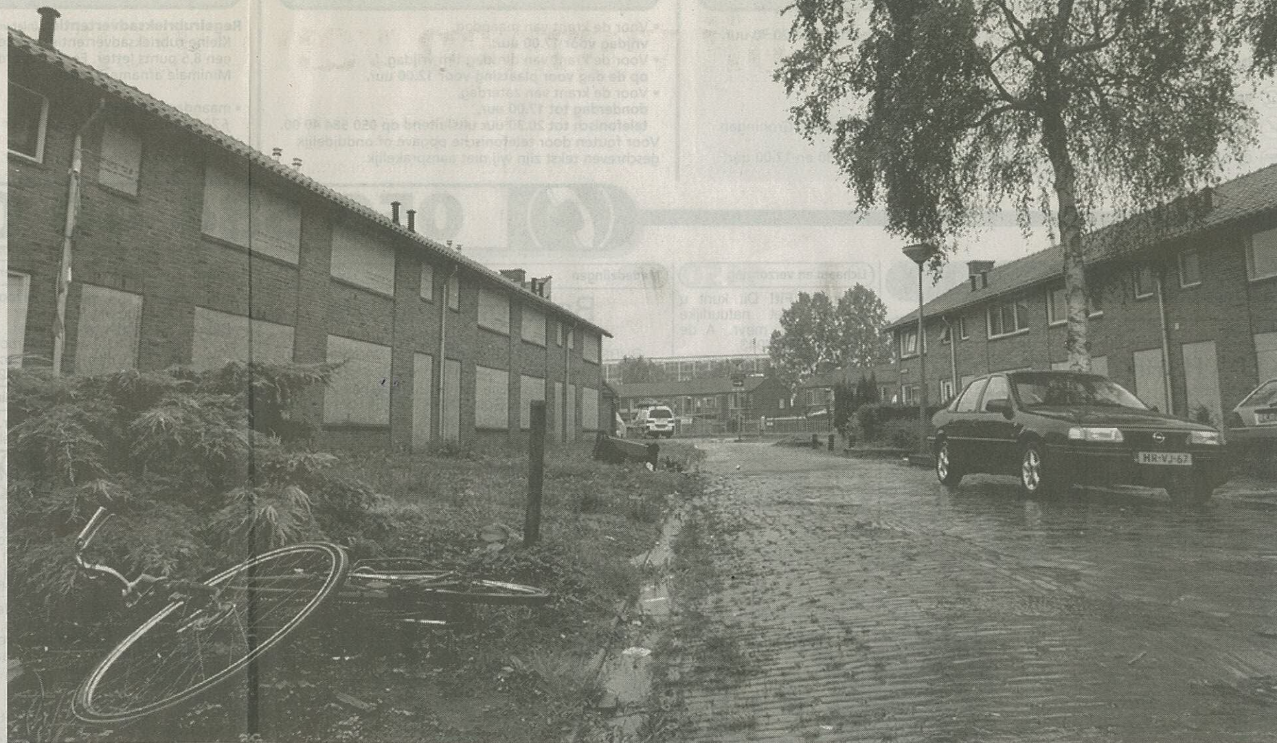
De woningen aan de Huygensstraat, waarvan op dit moment al het merendeel leeg staat, gaan allemaal tegen de vlakte. © NOORD NED FOTOPERSBURO
