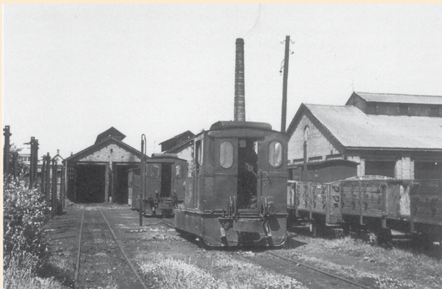
Op de achtergrond de locstalling met rechts de tramwerkplaats
