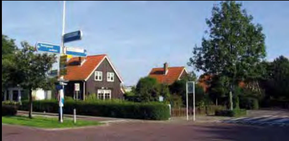
Houten noodwoningen Zeeland
