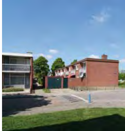
Te renoveren woningen
