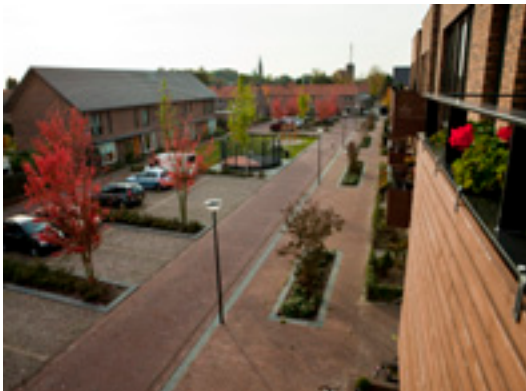
Kruising Einattenhof/Van Loëstraat, Molenakker. Door gerichte sloop in beide straten is de Einattenhof verbreed en vernieuwd
