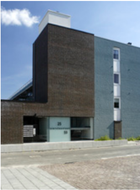
De Zwarte Hond, nieuwe hoofdentree voor opgedeel- de voormalige portiek- etageflat Siersteenlaan, Vinkhuizen, Groningen, 1998-2003
