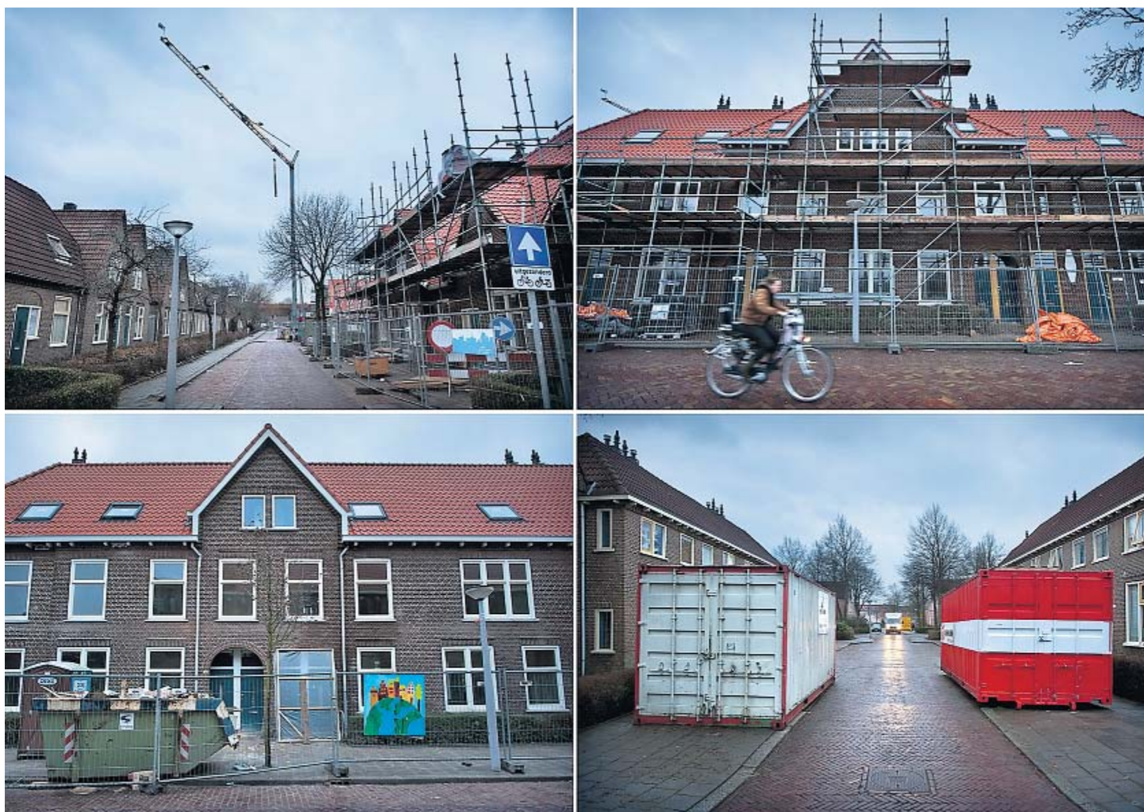
▲ Renovatie in de wijk De Hoogte. Linksboven: de Hermanstraat, rechtsboven: de Poortstraat, rechtsonder: De Hoogte en linksonder: de Cortinghstraat. Foto's: DvhN/Kees van de Veen
