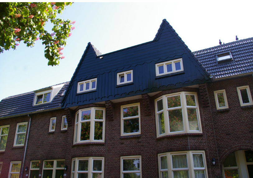
In Tuinwijk is gekozen voor kunststof kozijnen; de topgevels in hout zijn wel in ere hersteld.
