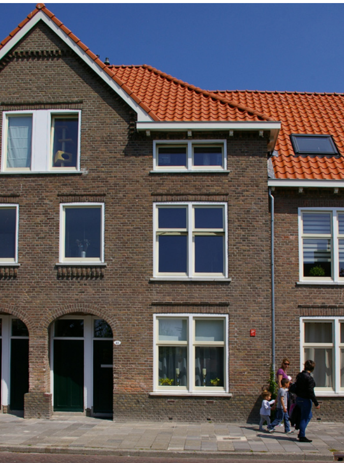
De Oude Hoogte, Borgwal. Terugliggende onderdorpels met tussenstijl die iets forser van maat is dan de buitenstijlen.
