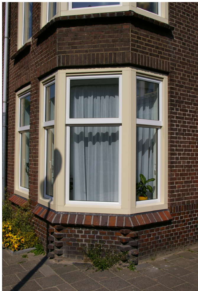
De kunststof kozijnen in Tuinwijk missen de details die bij hout (zoals in De Hoogte) juist voor de nodige plasticiteit zorgen.
