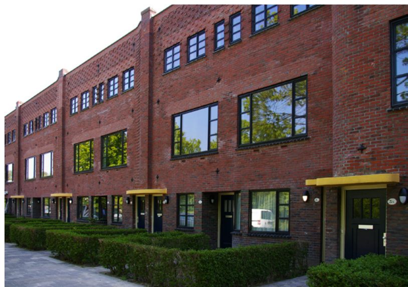
... plaats voor aluminium (2010), al waren de kozijnen in aanvang van staal (1932).
