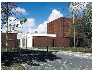
lucdevriesarchitect, Haarlem (Luc de Vries). Noorderhof Uitvaartcentrum Sem in Leeuwarden. Opdrachtgever: Noorderhof Vastgoed bv, Leeuwarden.
