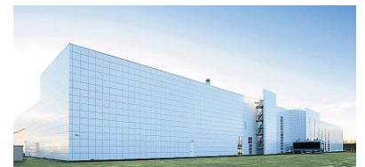
Bert van der Ploeg architectuur, stedenbouw, advies, Goutum (Bert van der Ploeg). CSK Culture plant en Energy plant in Leeuwarden. Opdrachtgever: CSK Food Enrichment B.V., Leeuwarden.
