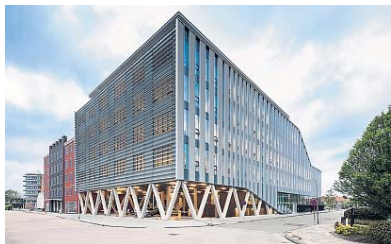
Architectenbureau Paul de Ruiter, Amsterdam (Paul de Ruiter en Noud Paes). Kantoorgebouw met callcenter en parkeergarage in Leeuwarden. Opdrachtgever: JOIN Ontwikkeling bv, Rotterdam. FOTO GERARD VAN BEEK
