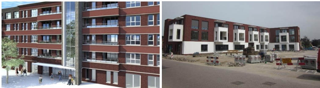
Nieuwbouw door de corporaties
