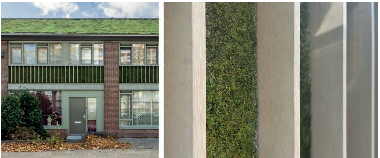
De gevel na de renovatie: de mospanelen zijn aangebracht tussen biobased lamellen van Resysta Recycle.
